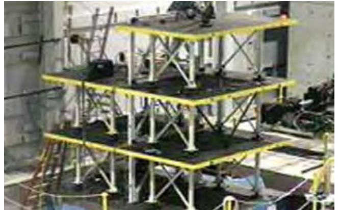
建筑钢结构包含Z形框架的振动测试
